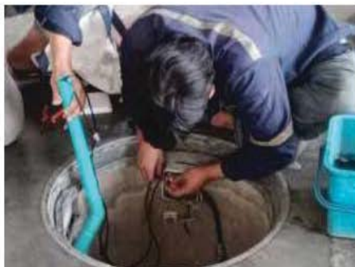
เจ้าหน้าที่ตรวจเช็ค และซ่อมบำรุงระบบบำบัดน้ำเสีย ภาพที่ 2.2-7 (ต่อ) ระบบการจัดการน้ำเสีย และสิ่งปฏิกูล
